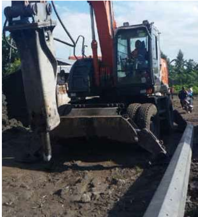
Creusage des trous pour l'implantation des poteaux différents moyens utilisés
