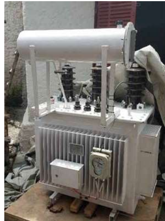
Transformateur 33/0.4 KV
