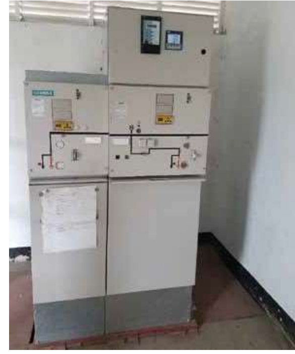
Cellule d'arrivée et Comptage
