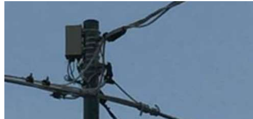
Compteur cashpower monophasé an'-fraude installé sur le poteau
