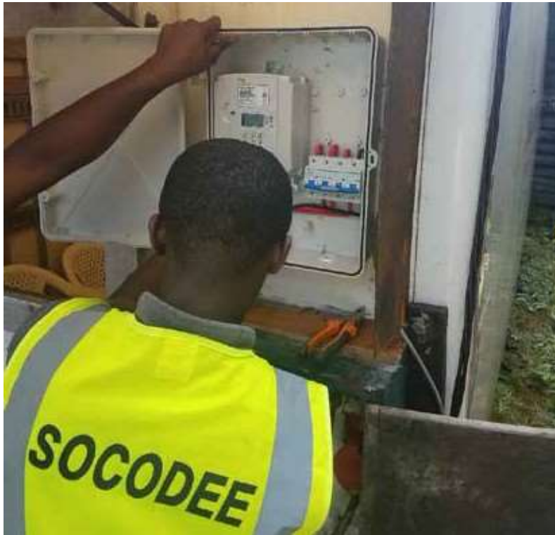
Installa'on d'un cash power triphasé
