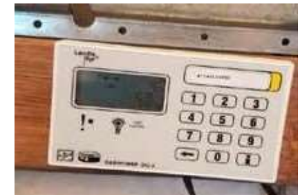
Compteur cashpower monophasé an'-fraude installé sur le poteau
