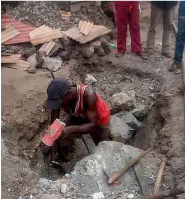
Creusage des trous pour l'implantation des poteaux différents moyens utilisés
