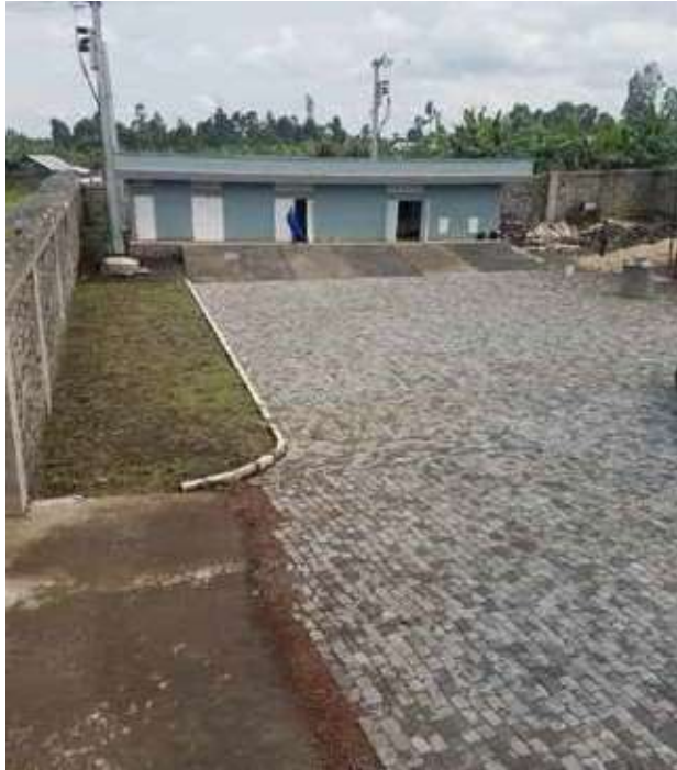
Sous sta(on Munigi
